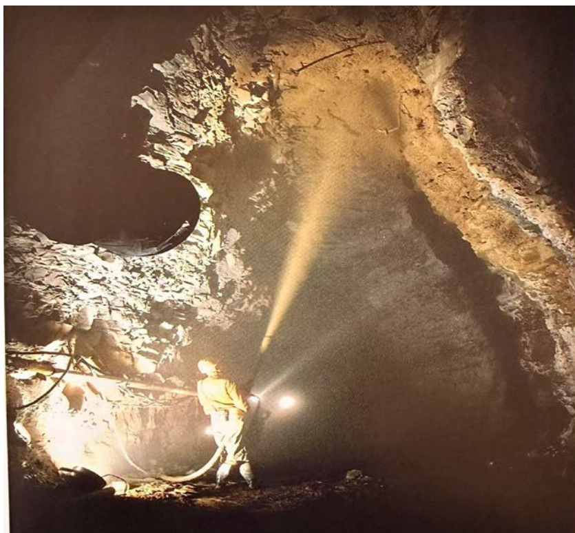
Сурет 4.11 – Қазбаларды бүрікпебетонмен беріктеу
