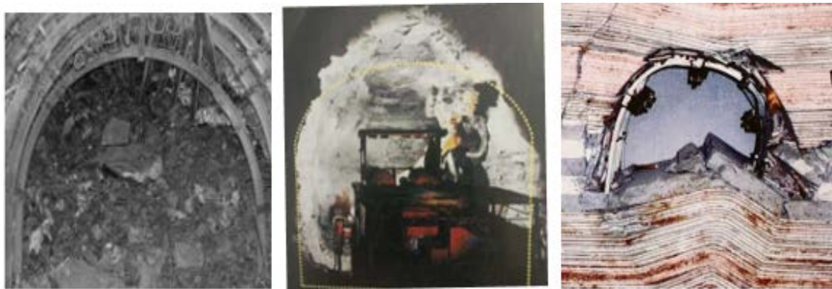
Сурет 4.9 - а) –кенжардағы опырылым; ә) қазба төбесінің бұзылуы; б) қазба табанының көтерілуі.
