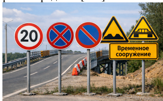
Рисунок 5.26 – Временные знаки, устанавливаемые перед путепроводом
