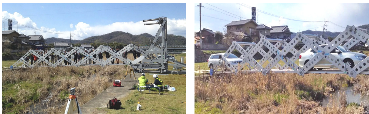
Рисунок 1.8 – Мобильный складной мост-оригами MB4.0
