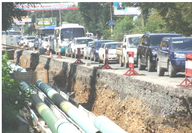
Рисунок 1.1 – Автомобильная пробка из-за подземного ремонта тепловых сетей
