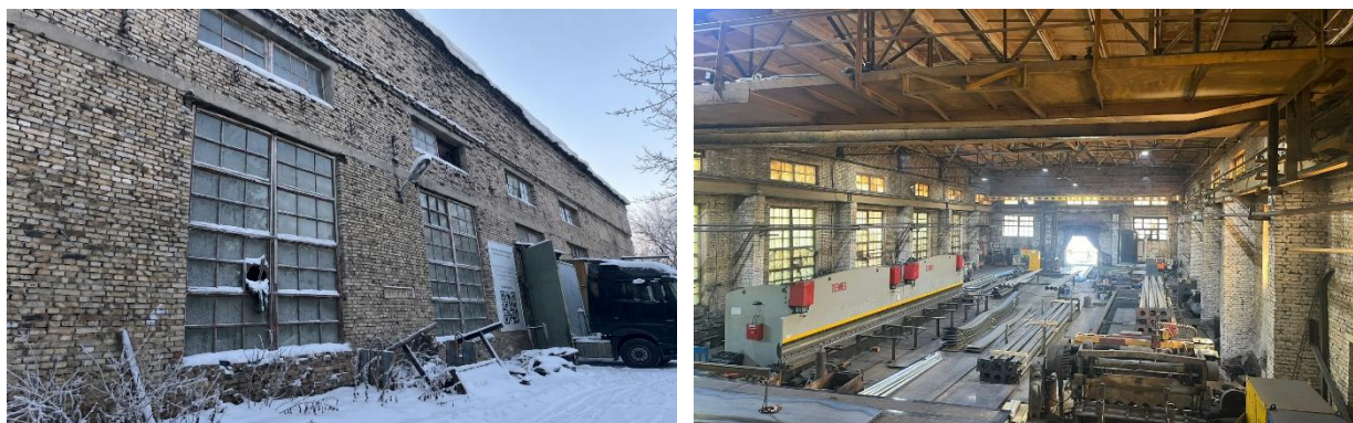
Рисунок 4.8 – Производственный корпус и рабочие зоны цеха
