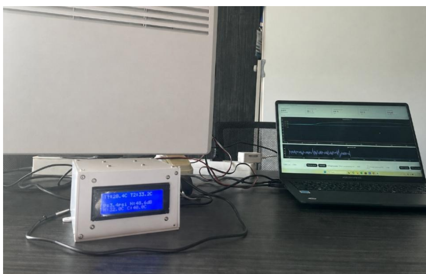
Рисунок 4.7 – Общий вид системы мониторинга ПЭНД с локальной индикацией и компьютерной визуализацией параметров
