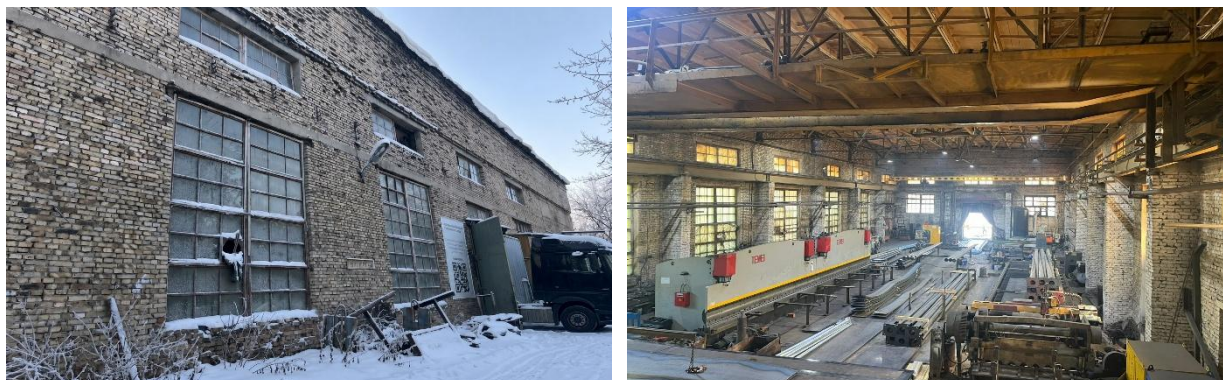
Рисунок 4.8 – Производственный корпус и рабочие зоны цеха
