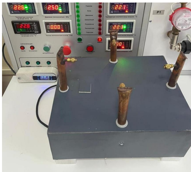
Рисунок 3.2 – Внешний вид лабораторного стенда для исследования электровакуумной секции ПЭНД
