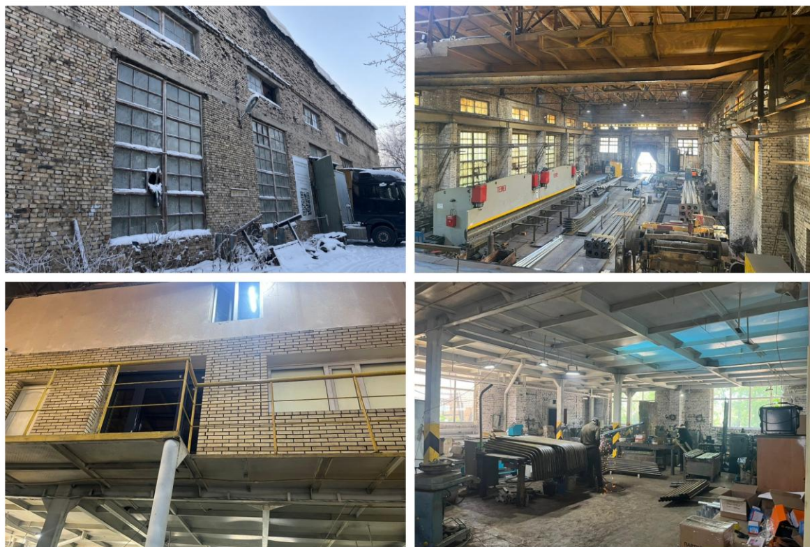
Рисунок 4.9 – Фотофиксация промышленного объекта: фасад с оконными проемами и воротной зоной; общий вид цеха; встроенный офисно-бытовой блок; рабочая зона с железобетонными плитами покрытия, фото автора; материалы обследования объекта [130]
