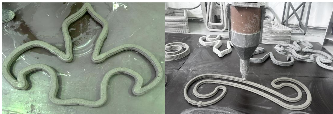
Сурет 4.4 — 3D-басып шығару процесінде жаңа дайындалған ұсақ түйіршікті бетон қоспасынан қабаттарды қалыптастыру
