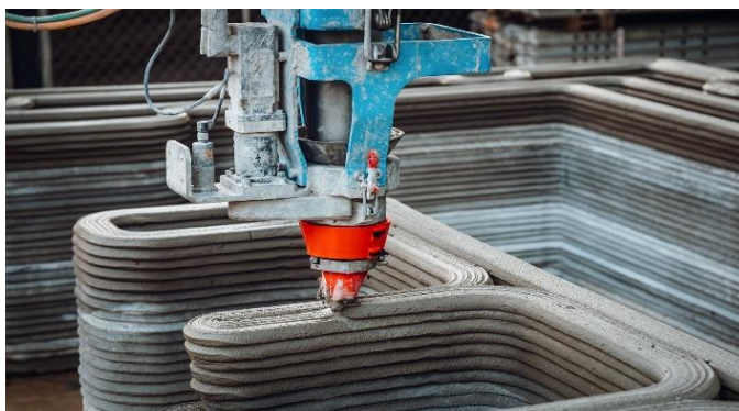
Сурет 1.2 – Қабатты экструзия әдісімен құрылыс конструкцияларын 3D-басып шығару процесі
