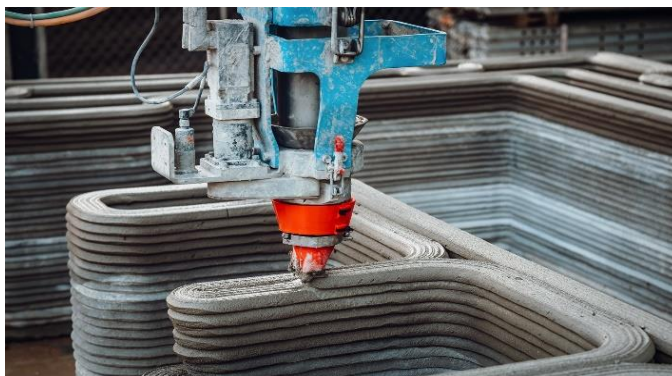
Сурет 1.1 – Қабатты экструзия әдісімен құрылыс конструкцияларын 3D-басып шығару процесі
