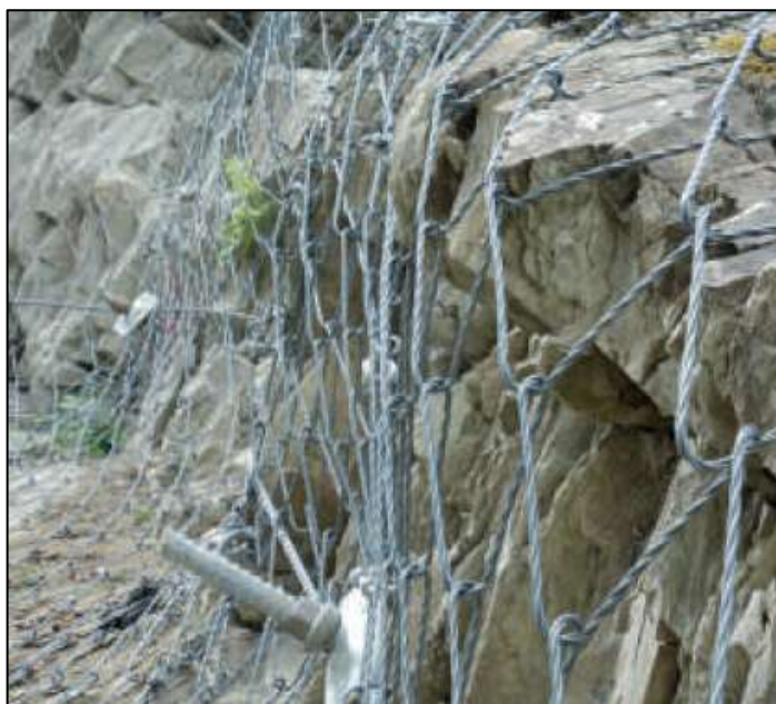
3.19-сурет – Спираль өрімді арқандардан жасалған тор жүйесі
