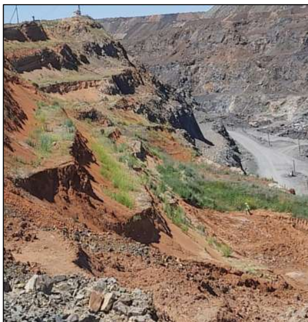
1.14-сурет – Карьердің солтүстік-шығыс беткейі (үстінгі сазды горизонттар суға қаныққаны, сазды кемердің сырғанауы бақыланады)
