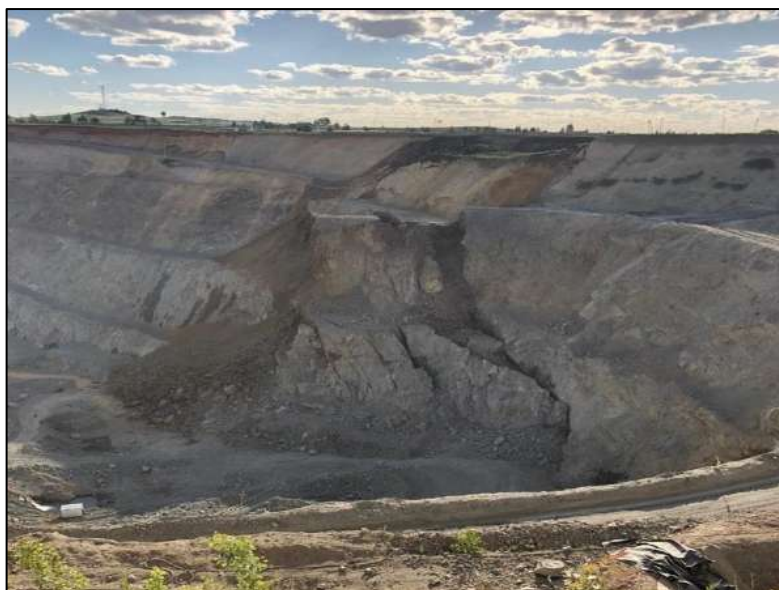
1.3-сурет – Батыс-Озерный карьерінің оңтүстік-шығыс беткей деформациясы
