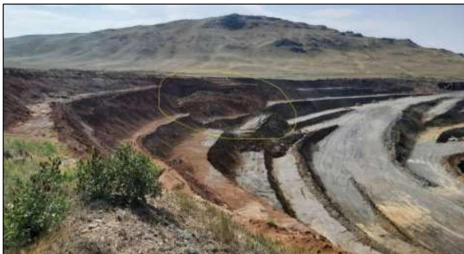
1.11-сурет – Карьердің солтүстік-шығыс және шығыс беткейлері (көктемде қардың мол еруінен судың серпілісінен туындаған қирау түріндегі сазды беткейдің жергілікті опырылуы)
