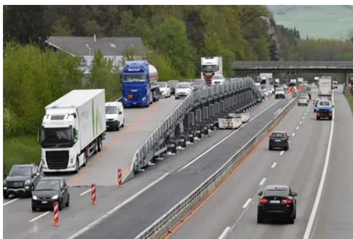
Сурет 1.8 – Швейцария автомагистраліндегі ASTRA Bridge модульдік жол өтпесі
