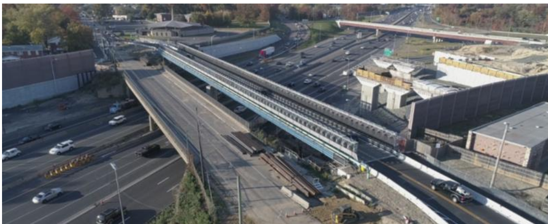
Сурет 1.6 – I-295 автожол айрығын қайта жаңарту кезінде айналма өткел ретінде орнатылған уақытша модульдік «Ascrow» жол өтпесі (2021)
