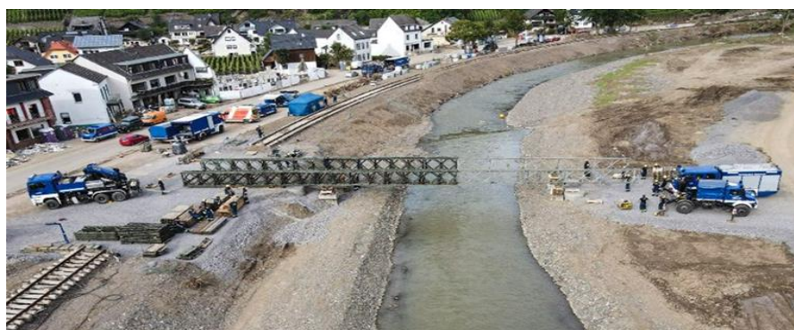
Сурет 1.5 – Германиядағы су тасқынынан кейін Бэйли типті көпірді орнату
