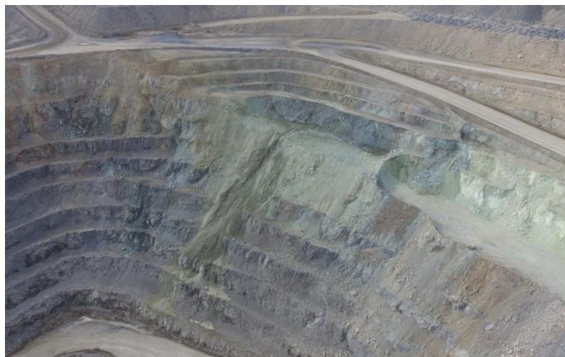
Рисунок 1- Деформация юго-западного борта карьера
