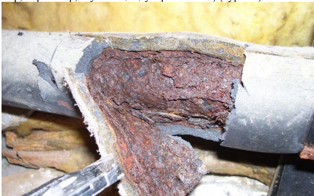
Рисунок 1. Коррозия трубопроводов
