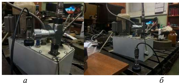
Рис. 2. Насосная станция с установленным датчиком вибрации: а – на станции; б – на основании
