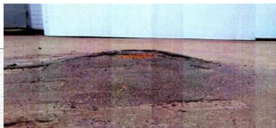
Рисунок 6-предполагаемые силы воздействия морозного пучения
