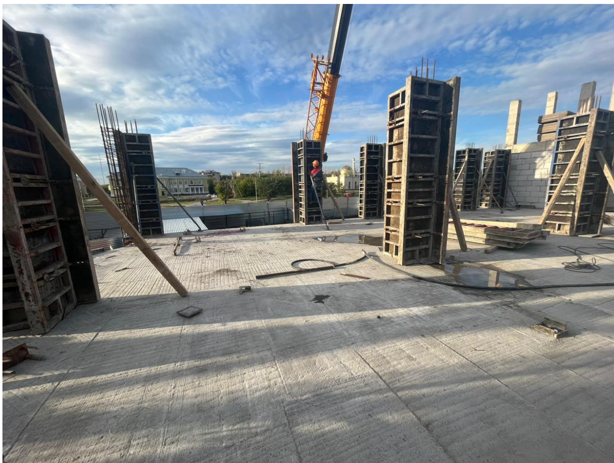
Рисунок 5.4 – Строительная площадка ТОО «Каздорстройтех»
