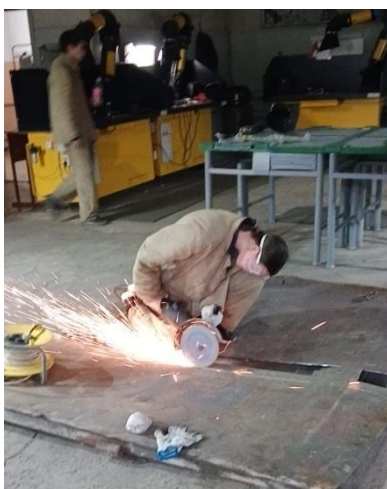
Проведение сварочных работ и термической резки студентами группы ДСО
