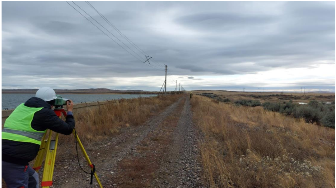
Рисунок 5— Нивелирование — важный этап валидации цифровых моделей и контроля вертикальных смещений.
