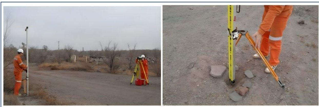
2-сурет –Эталон арқылы жер бетінің шөгуін өлшеу
