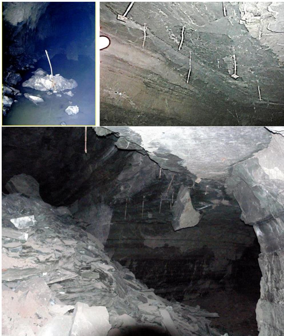
Рисунок 1.6 – Виды разрушений кровли очистных камер
