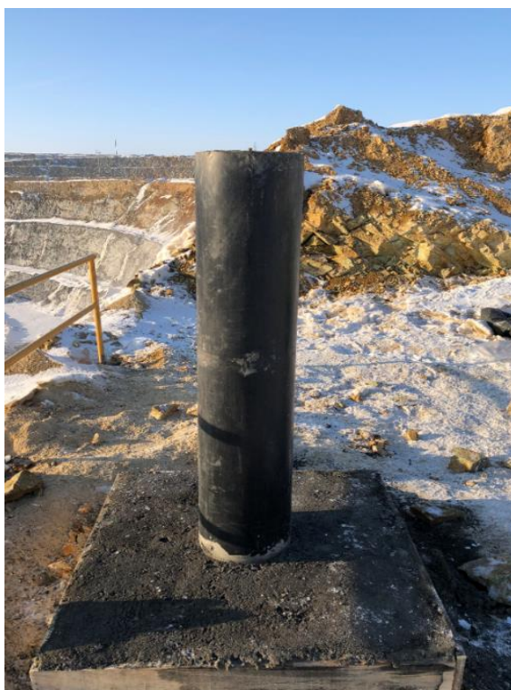
Сурет 4.24 – Құбырға бетон құю
