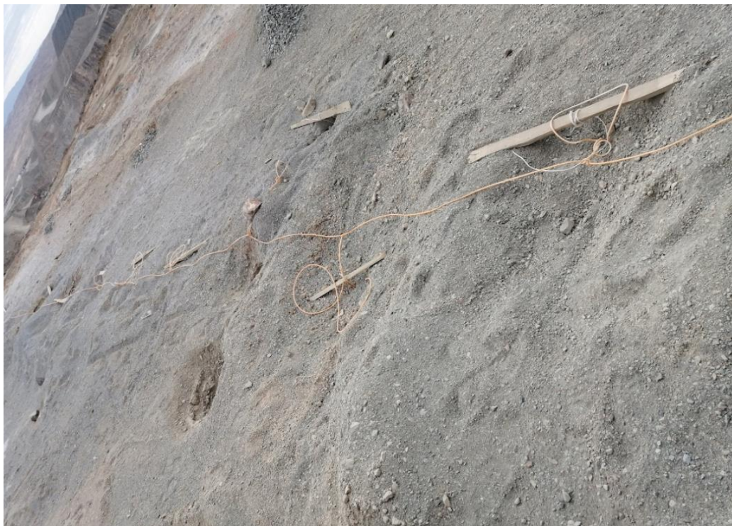
Сурет 4.14 – Алдын ала саңылау төтелдерін АЗ заярдау
