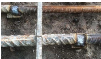
1.12 сурет - Арматураны түйістіріп дәнекерлеу
