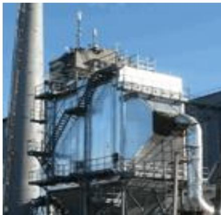
Рисунок 1.7 - Трубчатый электрофильтр
