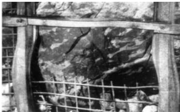
Сурет 2.6 – Ағаш бөренелерінің иілмелі қабаты бар қос жақтау түріндегі күшейтілген штрек тіреуі
