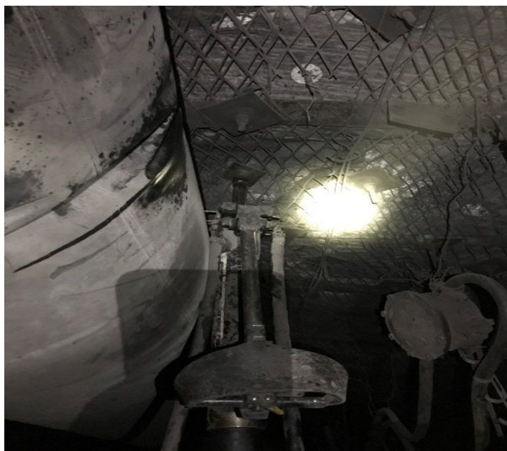
Сурет 6.5 – Арқанды анкер үшін тірек муфтасының астына теспені бұрғылаусыз құраушы анкерді орнату
