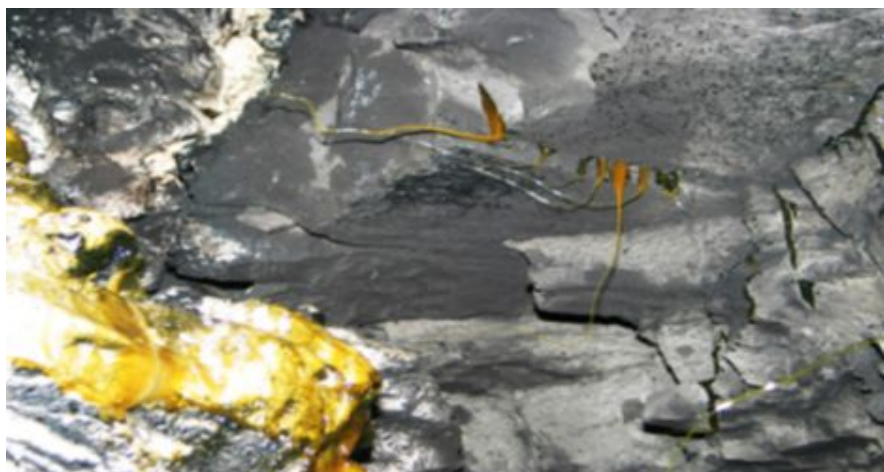
Сурет 2.11 – Екі компонентті полиуретан шайырымен бекітілген тау сілемі
