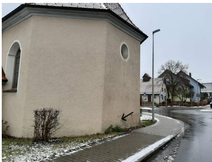
Рисунок 1- Осмотр геодезических сетей
