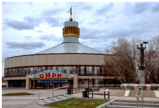
Рисунок 2 – Цирк после реконструкции
