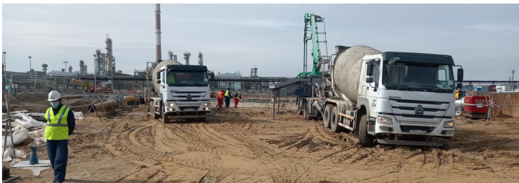
5.5 сурет – Бетон қоспасының тәжірибелік партиясымен дренаж жүйесінің қазаншұңқырларын бетондау барысы
