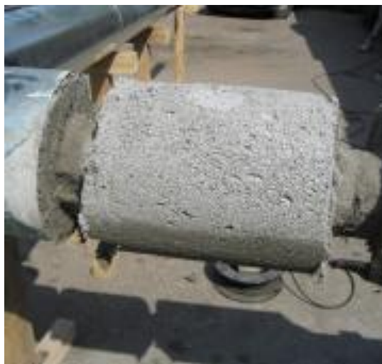
Рисунок 3 - Изоляция трубопровода пенобетоном
