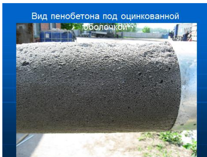
Рисунок 11 – Вид пенобетона под оцинкованной оболочкой
