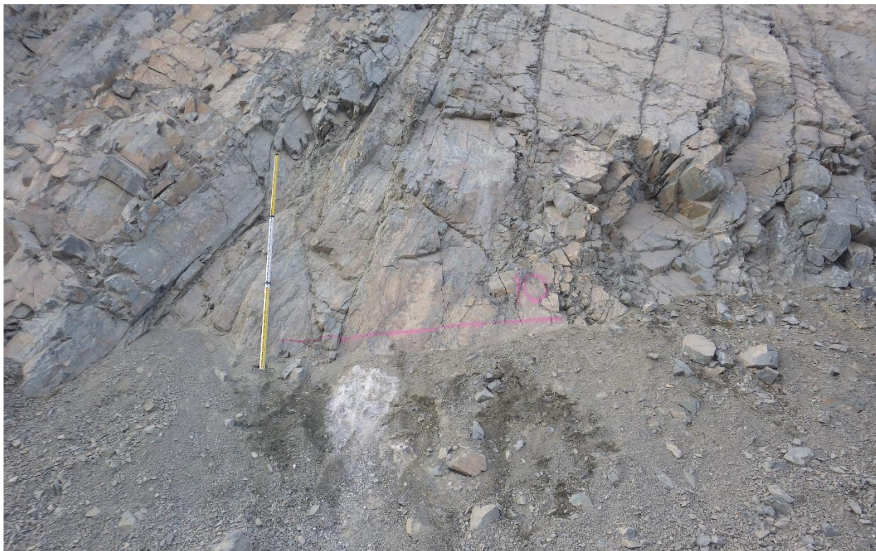
Сурет 3.26 – Жарылыс жұмысынан кейінгі шағын ақау (бұзылу)
