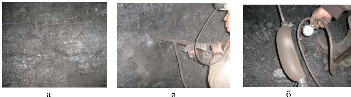
а – көмір қабаты; ә – сынама алу; б – манометрмен қысым бақылау
