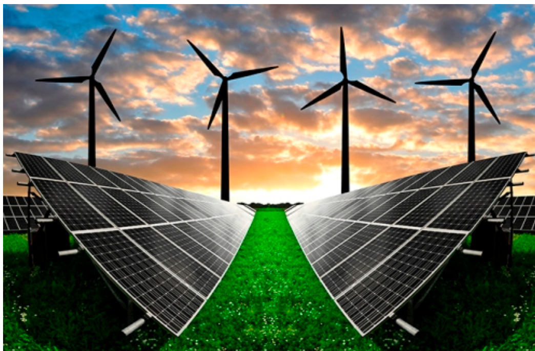
1 Сурет - Гибридті жел-күн электростанция
