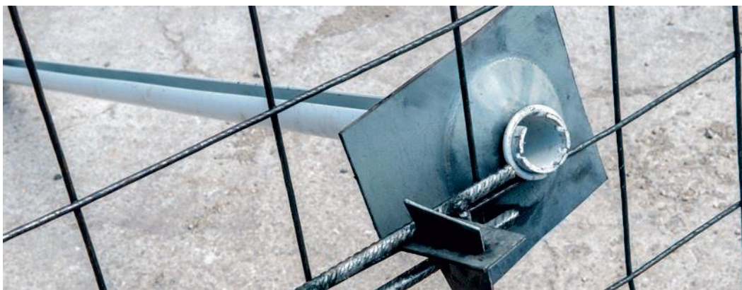
Рисунок Г.8 – Комбинированная крепь на основе СЗА
