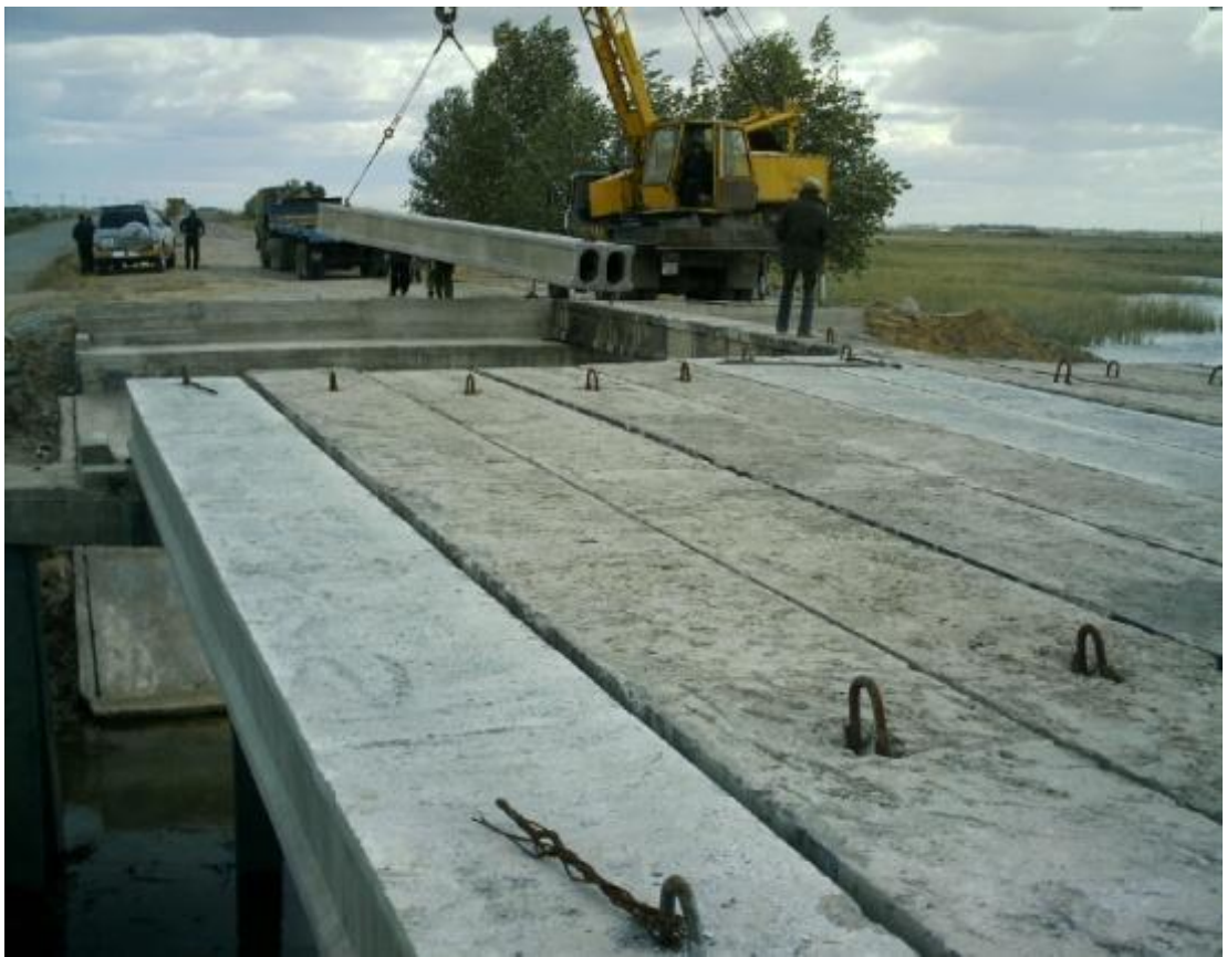
Капитальный ремонт моста через р. Ишим а. д. «Осакаровка – Молодёжное»
