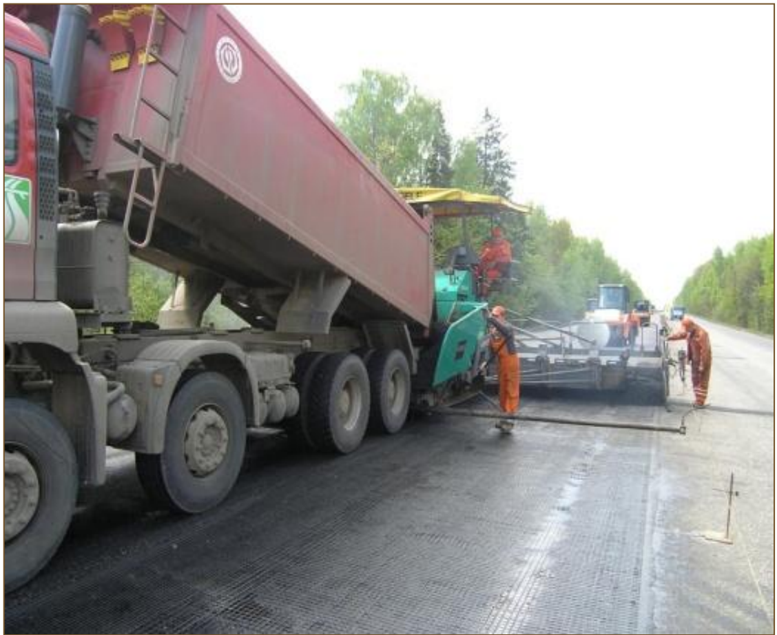
Реконструкция автомобильной дороги «Алматы- Астана»
