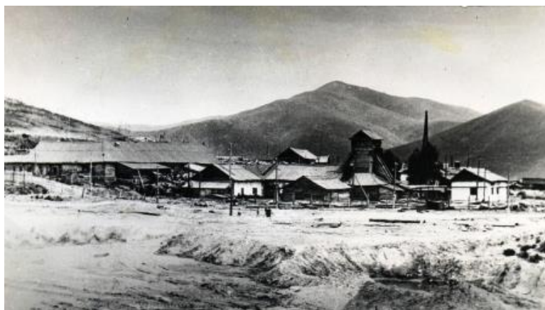
Старая промплощадка Зырянского рудника
