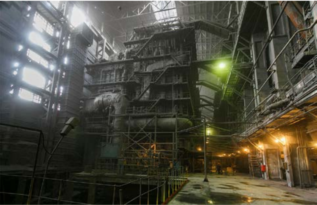
Рисунок 1 – Котельный цех Топарской ГРЭС
