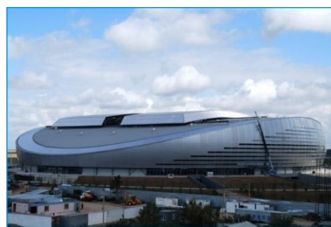
Экспертное обследование Крытого стадиона на 30000 мест
