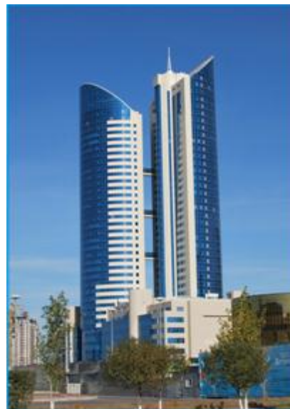
Мониторинг технического состояния МКВ АО НК «Қазақстан темір жолы»
